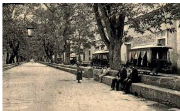
Figura 4. Vista de la Calzada de Guadalupe a finales del siglo XIX, donde se observan dos vagones del tranvía circulando por el corredor y la presencia de personas sentadas en las bancas laterales. La imagen evidencia la coexistencia entre movilidad moderna y prácticas tradicionales de sociabilidad, así como la incorporación del tranvía como nueva señal acústica asociada a la modernización urbana. Archivo personal del Mtro. Antonio Romo.
