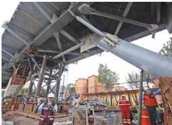
Foto 3. Acciones de reforzamiento de la Línea 12 tras caída en 2021. La jornada. 2022.
