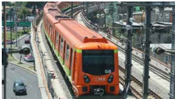
Foto 4. Tramo Elevado de la Línea 12. Proceso. 2023.
