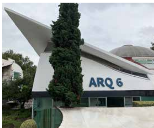
Figuras 1 y 2. Edificio ARQ6 La Monja (diciembre 2023 y junio 2025).
