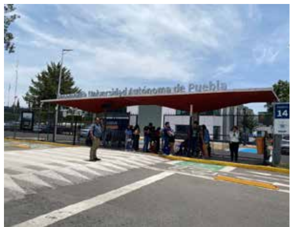
Figura 12. Paraboloides tipo paraguas invertido en la puerta 14 de CU (2024).
